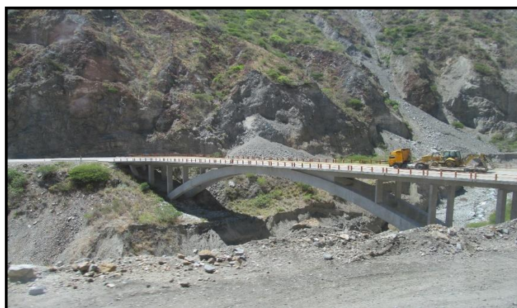
Puente Quebrada Honda, distrito de Curahuasi.
